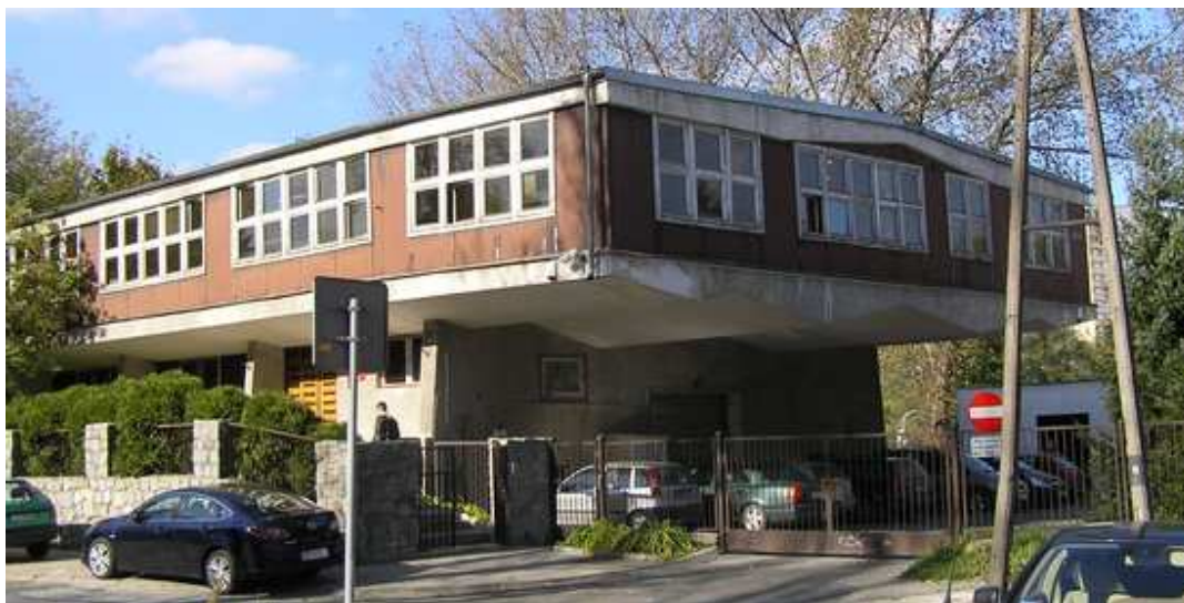
Fot. 1. Elewacja frontowa i wschodnia z bramą wjazdową na działkę.
