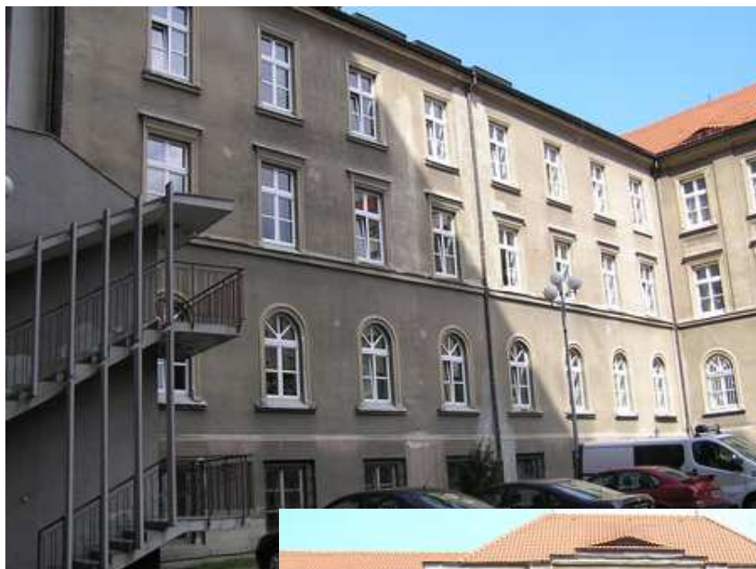
Elewacja południowa skrzydła północnego
