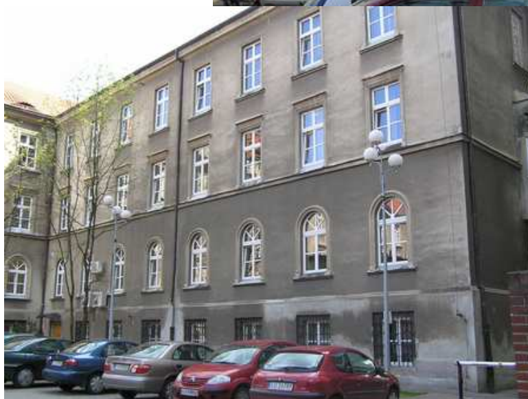
Elewacja północna skrzydła południowego
