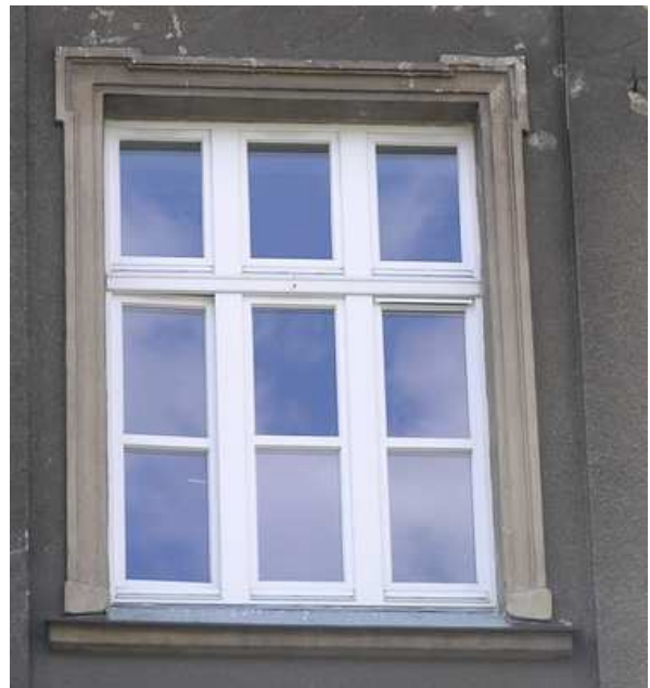
Fot. nr 8-11 - Lublin, ul. Spokojna 4. Widok okien na elewacji frontowej: piwnic, parteru (sklepienie łukowo) i II piętra (9-polowe)
