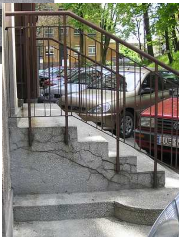
Fot. nr 24-25 - Lublin, ul. Spokojna 4. Widok schodów w elewacji południowej..
