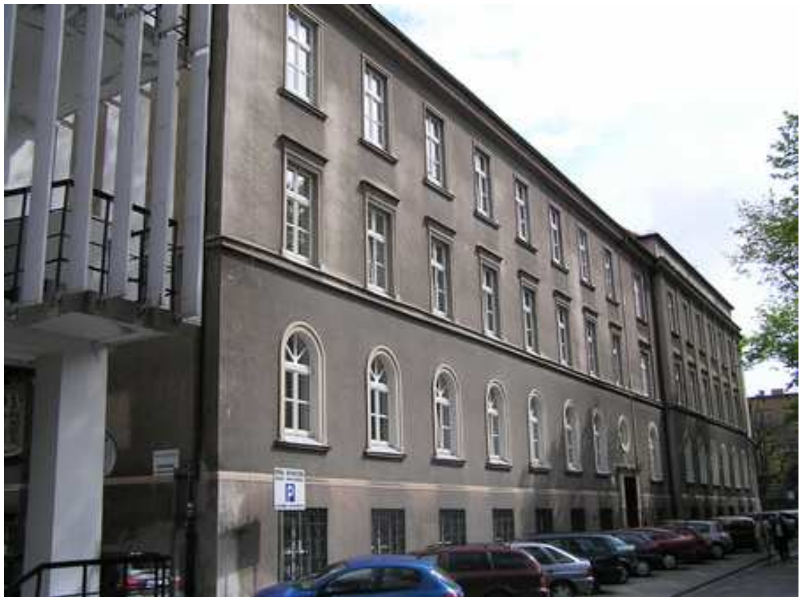
Fot. nr 14 - Lublin, ul. Spokojna 4. Widok ogólny elewacji południowej od strony ul. Tramecourta.
