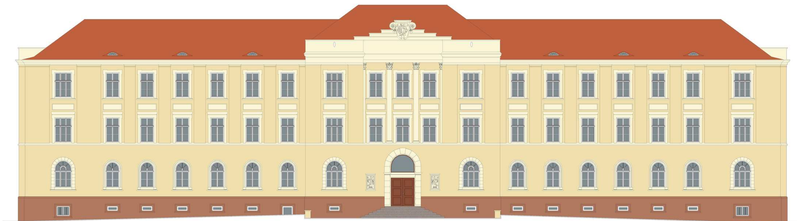
ELEWACJA FRONTOWA OD UL. SPOKOJNEJ
